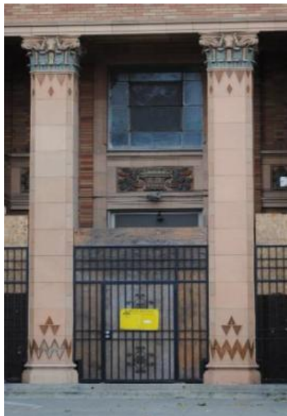
Int'l Blvd entry: restore doors, terra cotta
