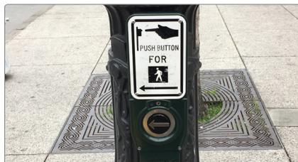
Los botones para peatones activan la fase WALK (paso habilitado) del peatón en las intersecciones señalizadas que no la proporcionan automáticamente.
